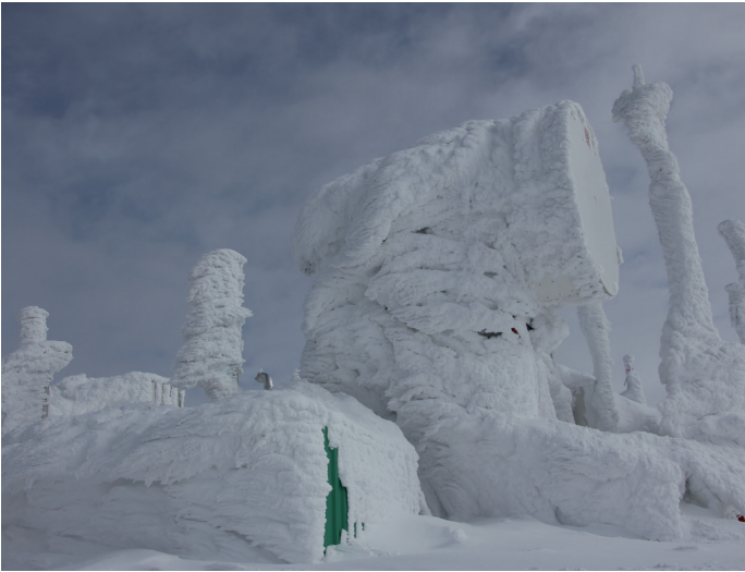
Sendeanlagen müssen auch unter extremen Bedingungen funktionieren. (Bild: Sendeanlage in den niederösterreichischen Kalkalpen im Wintergewand)
