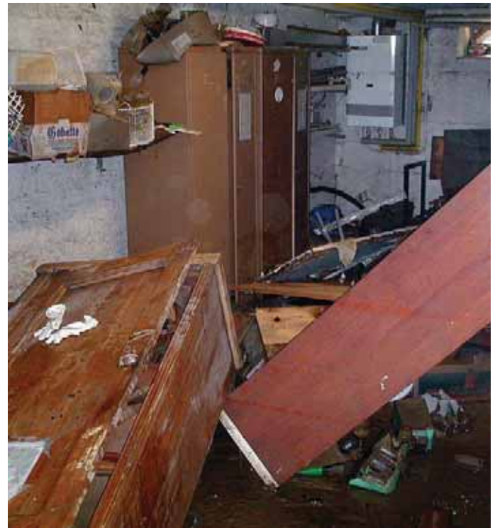
Keller nach dem Hochwasser 2002 in Hadersdorf-Kammern
