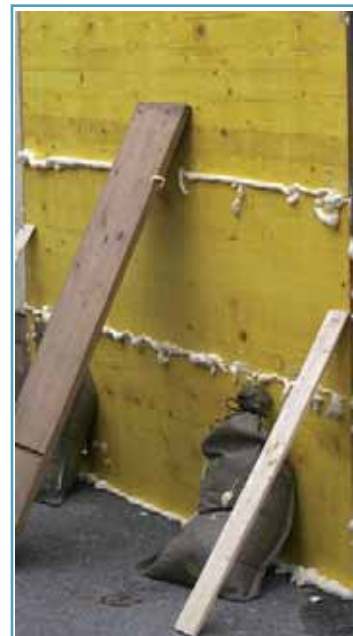
Behelfsmäßiger Gebäudeschutz mit PU-Schaum (Montageschaum) und Doka-Platten
