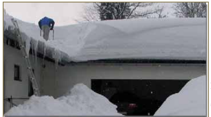
Massive Schneefälle können gewaltige Schneelasten auf den Dächern verursachen. Daher auf die Statik des Dachstuhls Rücksicht nehmen.
