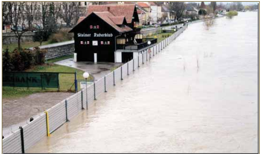
Der mobile Hochwasserschutz in Krems und Stein wird von der örtlichen Feuerwehr bei drohendem Hochwasser aufgebaut und er hat schon mehrmals große Schäden verhindert. Ein typisches Beispiel öffentlicher Vorsorge von Donaugemeinden.
