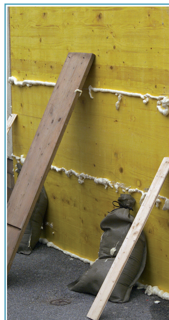
Behelfsmäßiger Gebäudeschutz mit PU-Schaum (Montageschaum) und Doka-Platten
